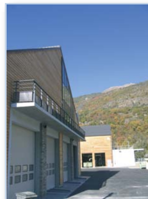
La nouvelle unité de traitement des eaux usées du Briançonnais
