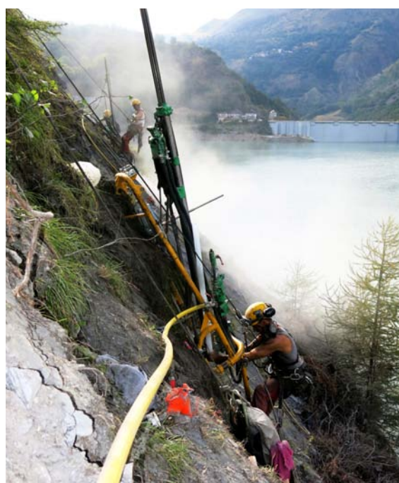
Construction de l'itinéraire bis
