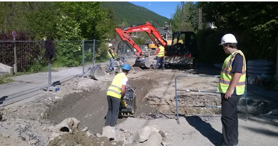
BOULEVARD DU LAUTARET TRANCHE 1, BRIANÇON
