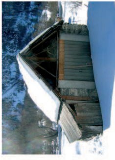
la toiture est posée sur des murs latéraux en pierre, la porte est traitée en remplissage. Le pignon est couvert mais il pourrait être traité en remplissage bois
