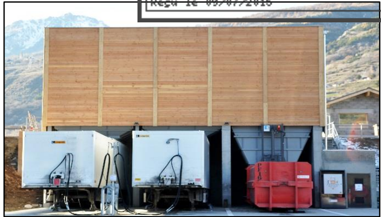
Quai de transfert, Villar-Saint-Pancrace
