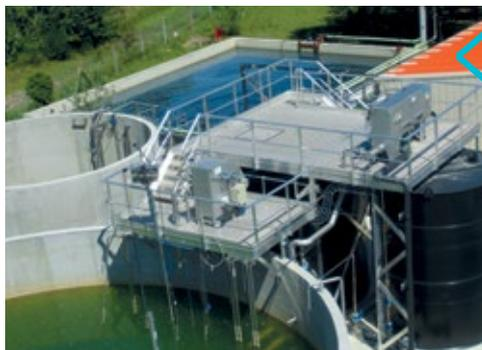
**novembre :** l'usine Expansia d'Aramon (30) se dote d'une installation de pointe pour traiter ses effluents industriels. Les 180 m<sup>3</sup> rejetés quotidiennement dans le Rhône seront désormais épurés à 95 %, contre 50 % auparavant. D'un montant de 1,5 M€ cette station est financée en partie par l'agence de l'eau.
